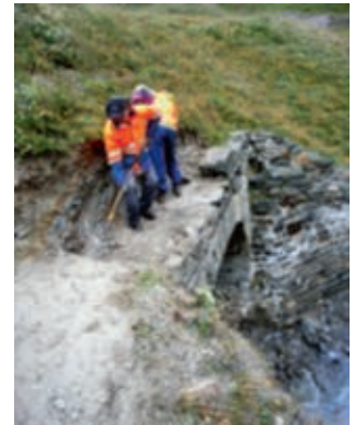
Räumung des oberen Brückenkopfs durch Andreas und Patrick / Dégagement de la tête amont par Andreas et Patrick
