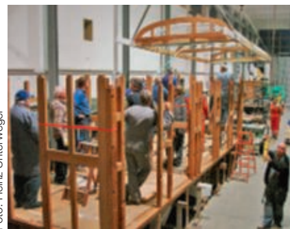
Das Dach des B 2206 schwebt ein, um auf die Träger des Kastens aufgesetzt zu werden / Le toit du B 2206 est posé sur les supports de caisse
