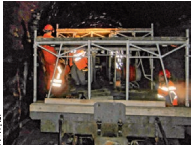
Arbeit im Tunnel 3 unter dem Schutz eines umgebauten Güterwagens Travail dans le tunnel 3 à l'abri d'un wagon marchandises modifié
